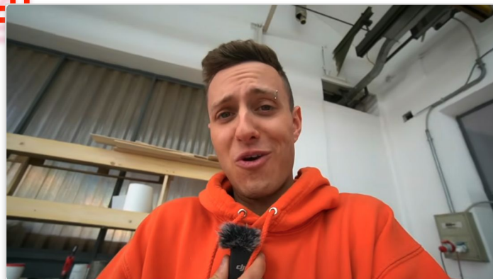
COSTRUIAMO un SOPPALCO GIGANTE in CAPANNONE! RISTRUTTURO IL CAPANNONE EP.9
